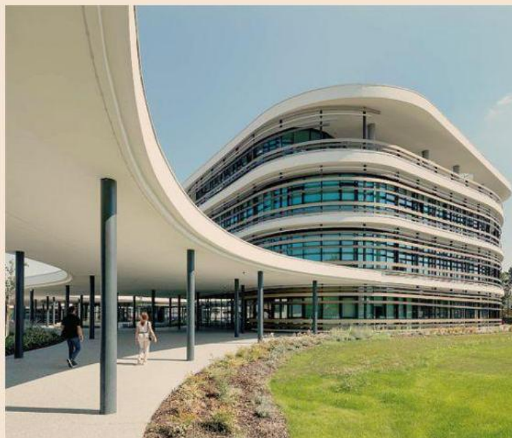
La sede. Il nuovo centro direzionale green
