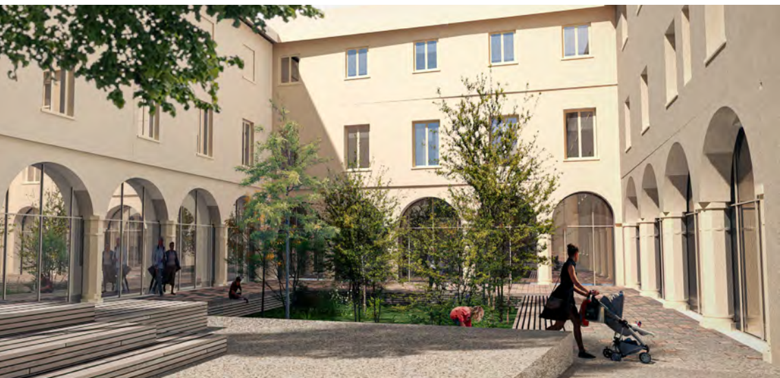
Palazzo Roverella corte interna e aree verdi riqualificate
