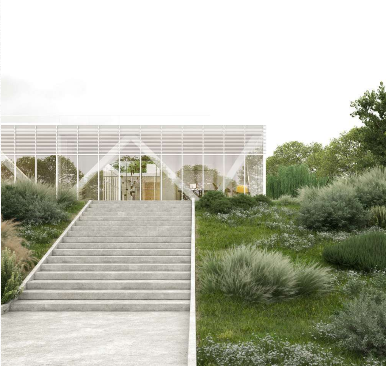
Nuovo Sito Produttivo Kerakoll, Sassuolo
