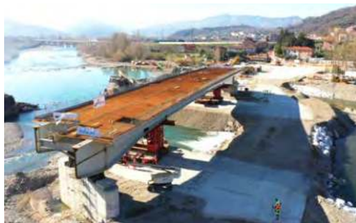
Nuovo Ponte di Albiano modello BIM dell'intera infrastruttura e foto del cantiere durante il varo della campata principale
