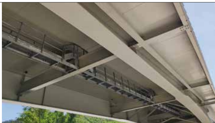
6. L'intradosso "vuoto" dell'impalcato con la passerella di ispezione
