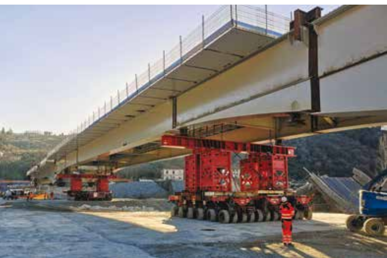
13. La posa in opera della campata P1-P2 con la predisposizione per la saldatura in opera
