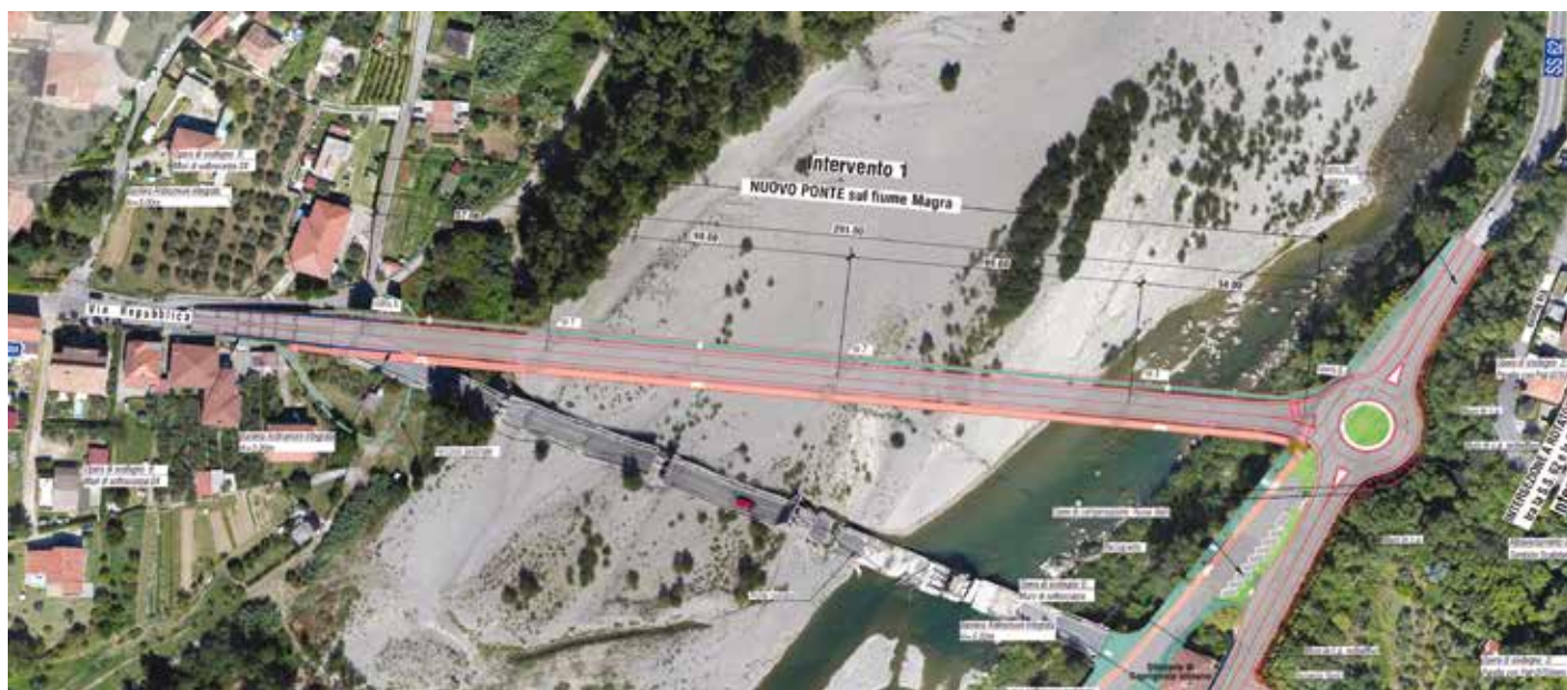
7. Il nuovo tracciato stradale
