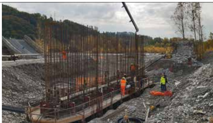
10. L'armatura del fusto della pila P1
