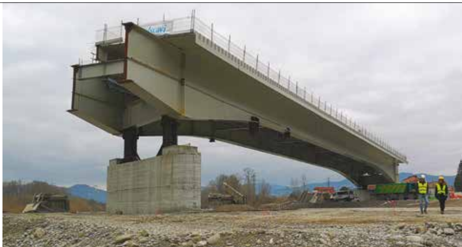
12. La campata P2-P3 posta in opera per prima
