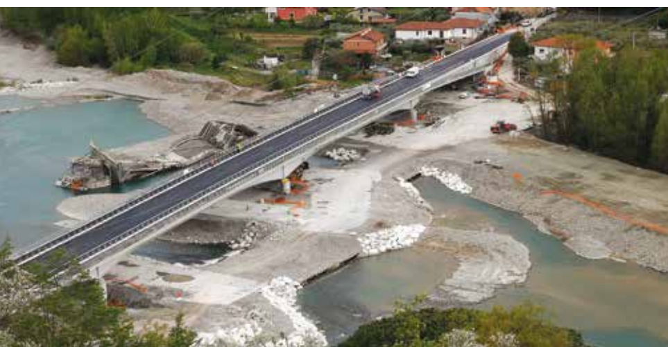
14. Il ponte sul fiume Magra, ormai completo, a Pasqua 2022, visto da Caprigliola con le rovine del ponte crollato in fase di rimozione
