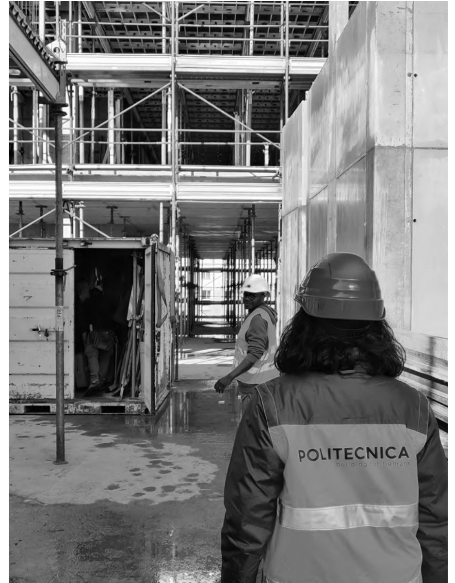
Cantiere Unimib U10 Logos, Milano.
