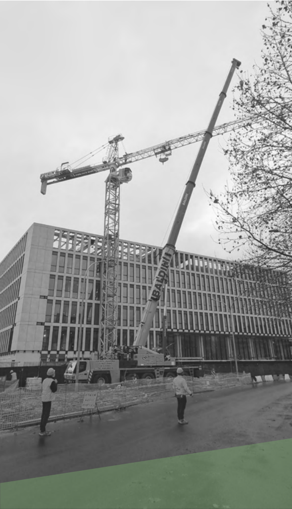
Cantiere Crif21, Bologna.
